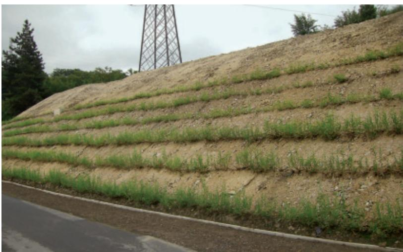
Imagen del talud sostenido con técnicas de bioingeniería
