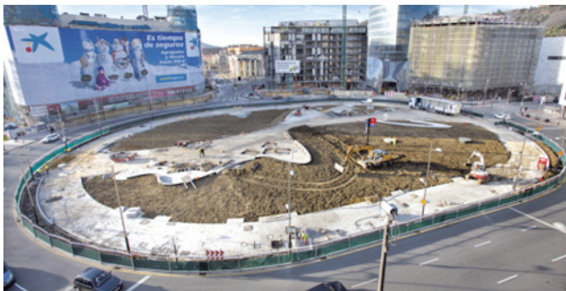
La plaza Euskadi tiene sus caminos trazados y están en marcha los trabajos de jardinería
