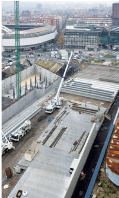
Las vigas conforman tableros de diferentes tamaños
