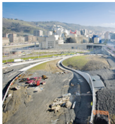
La estructura del parque está casi concluida
