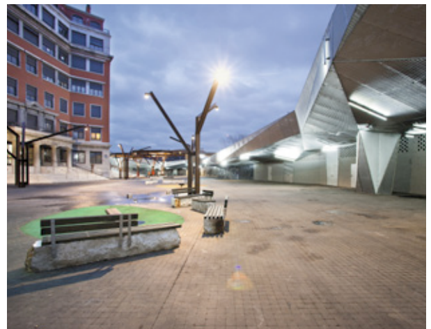
Zona de descanso junto al antiguo edificio de oficinas de Altos Hornos
