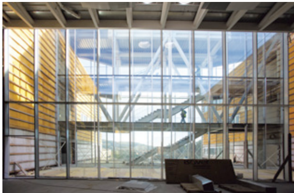
Patio interior del edificio de Bomberos desde la pista polideportiva
