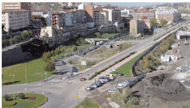
En la parte inferior derecha, la parcela vendida, junto a la Avenida de Altos Hornos
