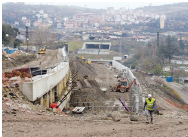
Vista de la obra desde la glorieta de Torres Quevedo
