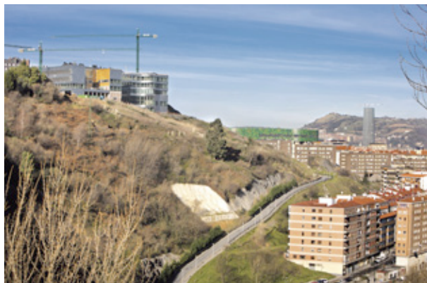
El edificio de Policía y Bomberos, desde Miraflores
