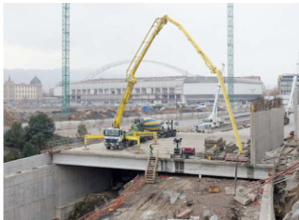
Proceso de colocación de vigas
