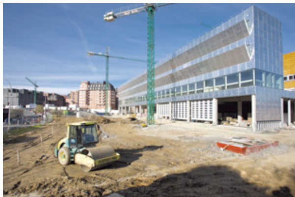
Lugar donde se levantará la torre de entrenamiento
