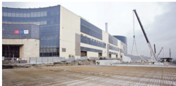
Estado de las obras junto al edificio Bami
