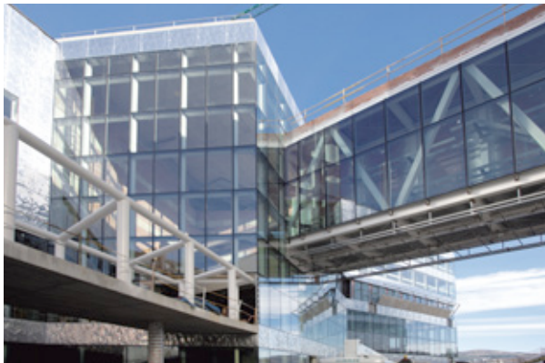
A la derecha, pasarela de conexión entre los edificios de Policía y Bomberos
