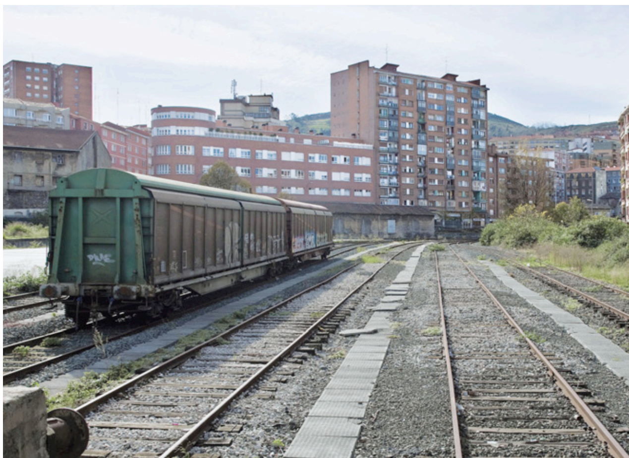
Vista actual de la playa de vías de Pozokoetxe
