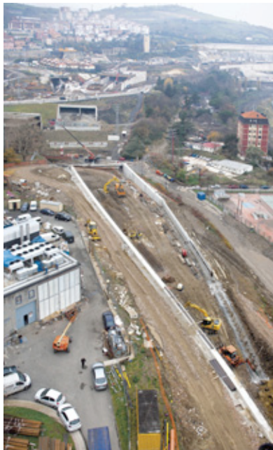
Vista aérea de la obra
