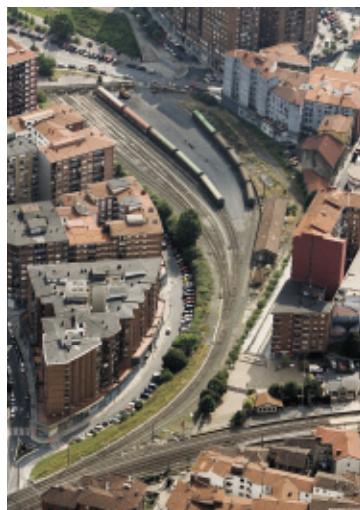
Vista aérea de la playa de vías de Pozokoetxe
