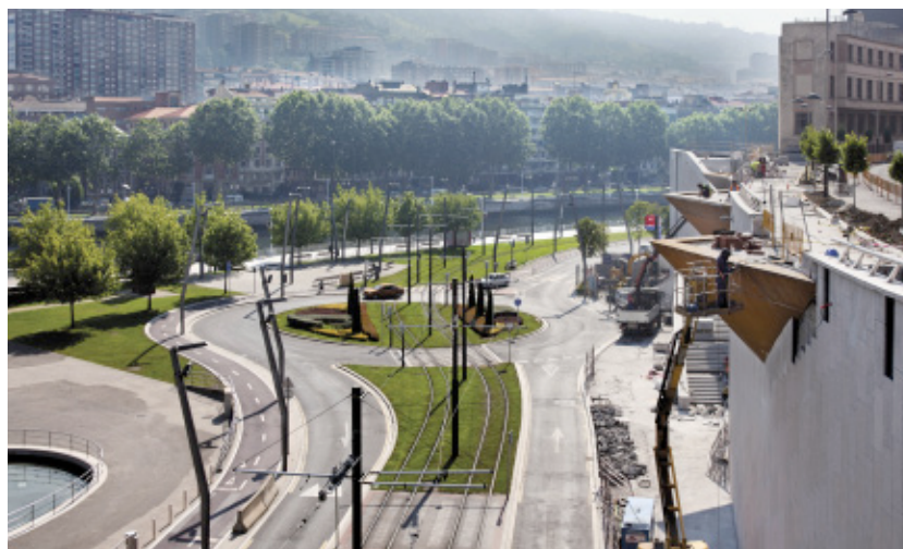
La Alameda de Mazarredo dispone de miradores hacia la Ría
