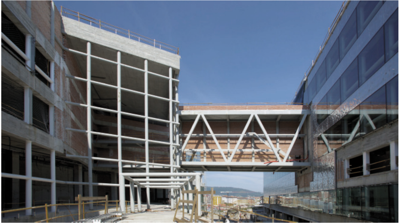
Pasarela que une los dos edificios y que albergará una biblioteca y un centro de documentación
