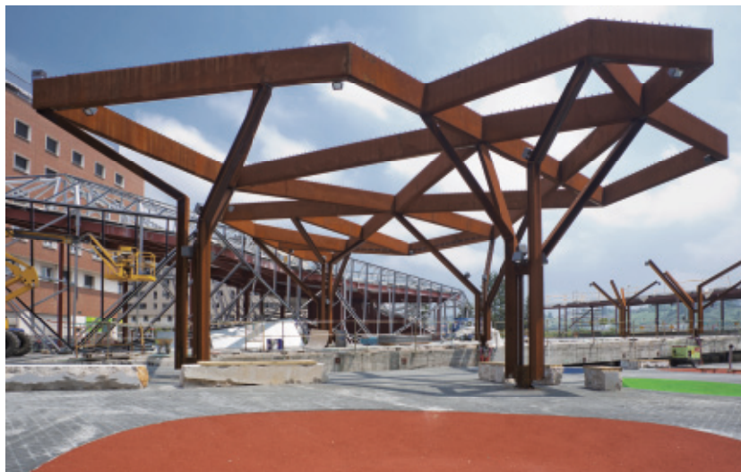
Estructura metálica en el centro de la plaza
