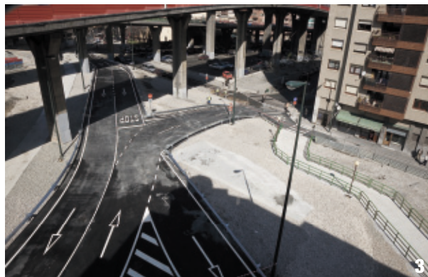
Bajos del viaducto de Sabino Arana (2010)
