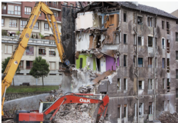
Derribo de edificios en la calle El Carmen
