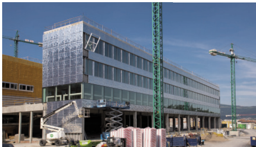
Vista general del edificio de Protección Civil
