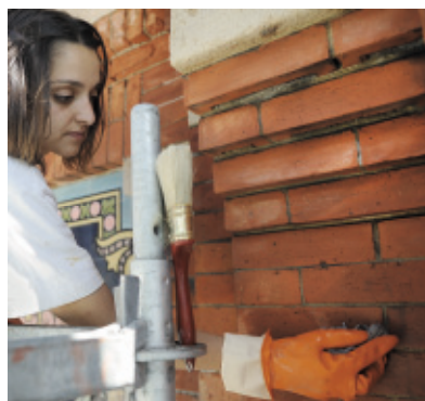
Restauración de la fachada
