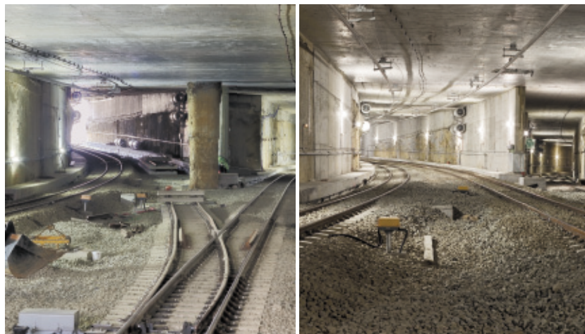
La eliminación de un pilar del puente del "camello" ha permitido habilitar la doble vía
