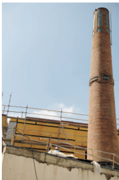
La chimenea tras su rehabilitación
