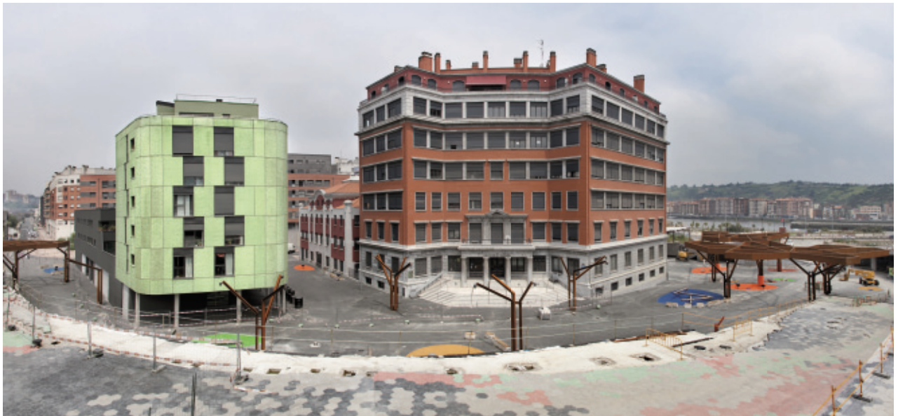
Vista panorámica de la actuación
