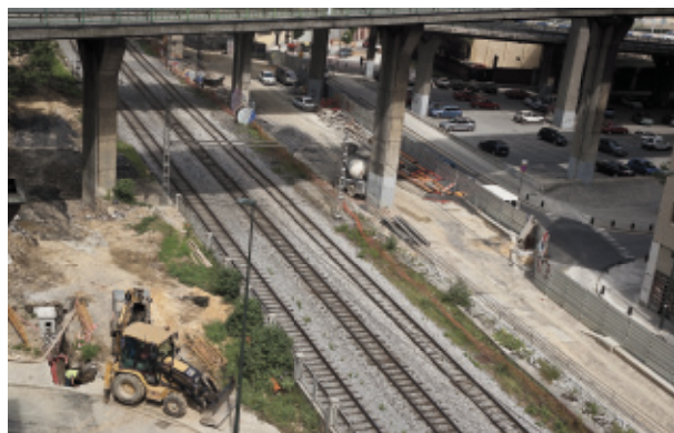
Bajos del viaducto de Sabino Arana (2005)
