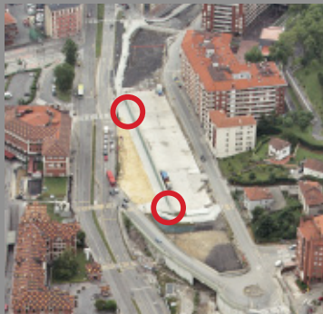
Accesos a la estación
