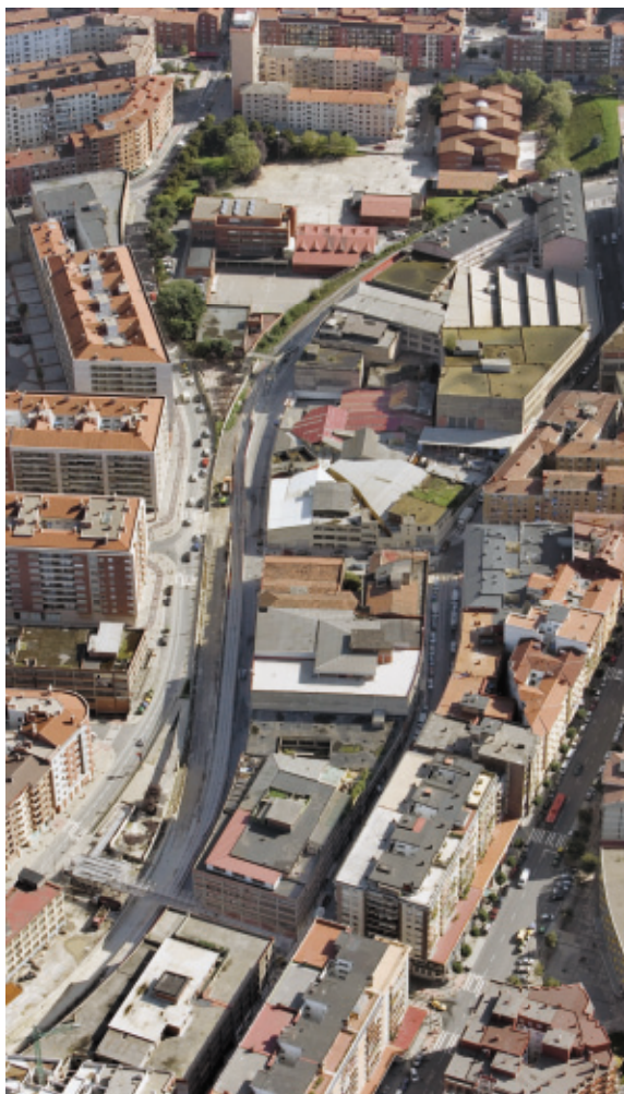
Vista aérea del tramo de la línea de mercancías de Feve que será soterrado
