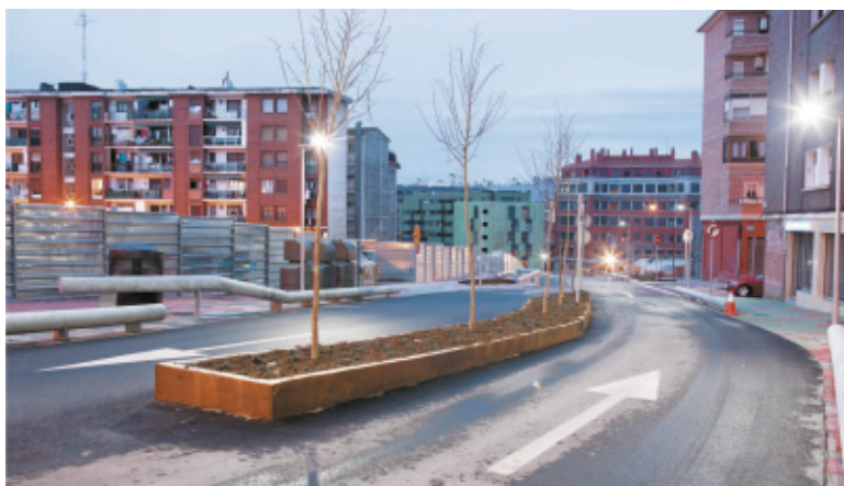
La zona más alta de la calle Pormetxeta ya ha sido urbanizada
