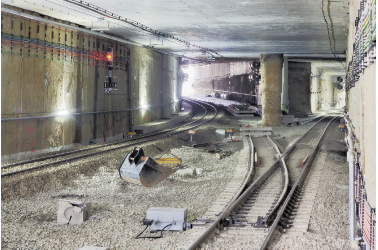
En esta imagen se aprecia el pilar del puente entre Urkiola y Camilo Villabaso que impide de momento habilitar la doble vía
