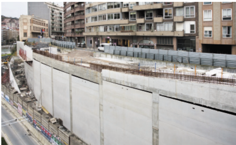
Exterior del aparcamiento subterráneo
