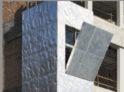
La fachada quedará revestida con chapa de aluminio
