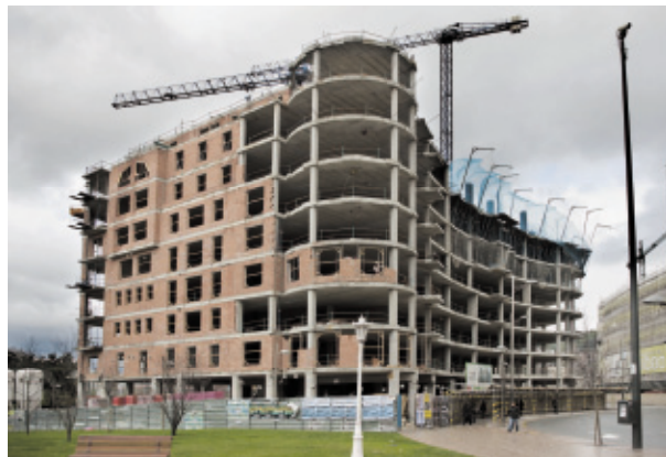
Edificio de viviendas junto a la plaza de Euskadi
