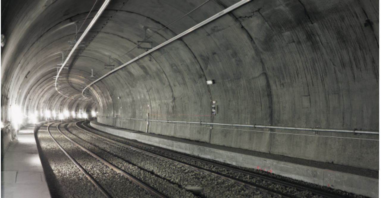
Interior del túnel excavado
