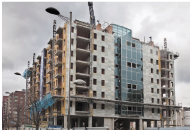
Edificio de viviendas frente a Zubiarte
