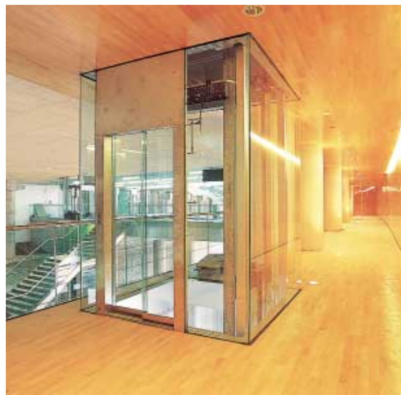
Uno de los dos ascensores que permiten acceder a los andenes
