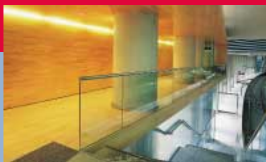
Estación de Ametzola
