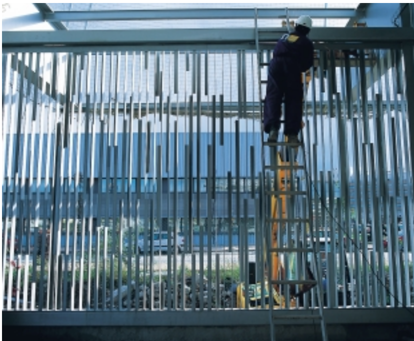
Obras del campo de fútbol
