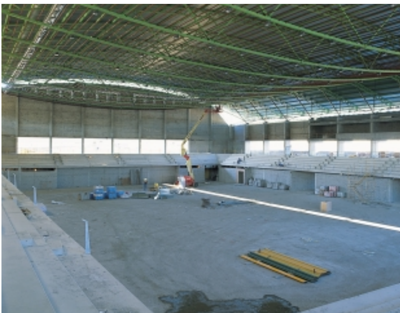
Vista del interior del polideportivo de Lasesarre
