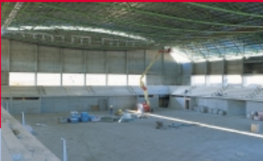
Obras del polideportivo de Lasasarre, Barakaldo
