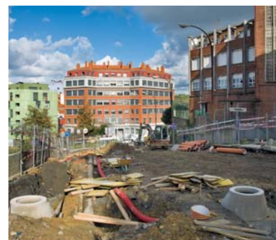
Vista de las obras desde la calle Pormetxeta
