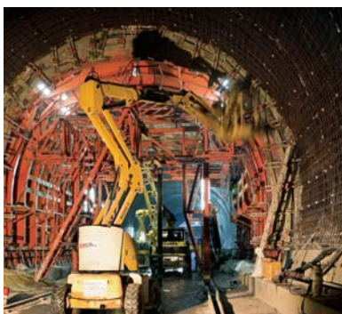
Vista del túnel
