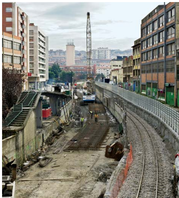
Ejecución del tramo de enlace en Irala
