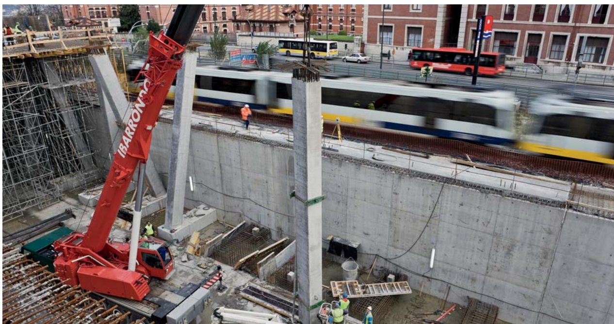
Zona en la que se ubicará la estación Hospital
