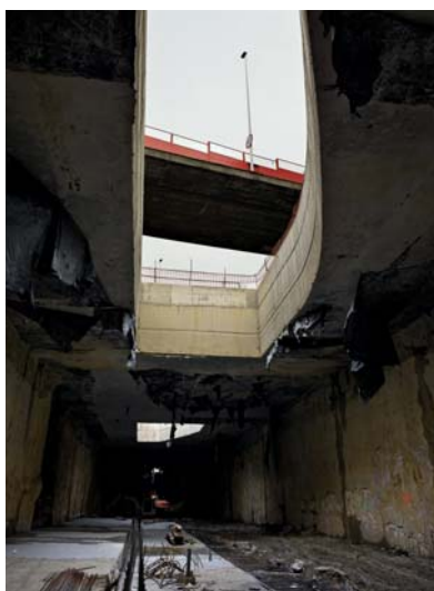
Las obras avanzan a buen ritmo
