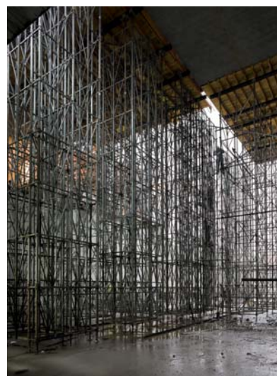
Detalle de la obra
