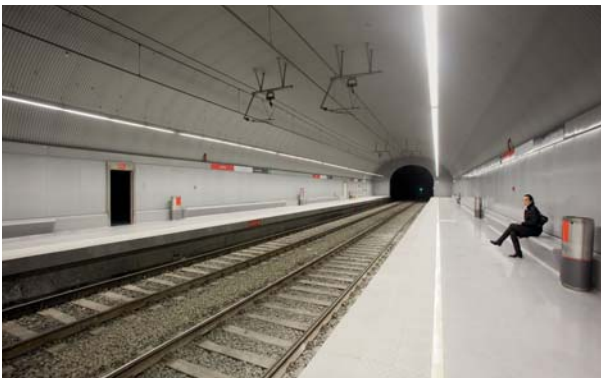
Interior de la caverna de la estación
