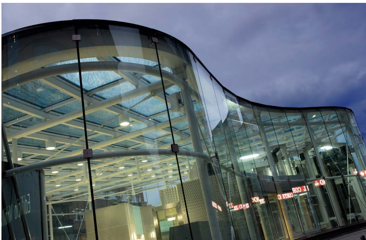
Vista parcial del exterior del vestíbulo de la nueva estación
