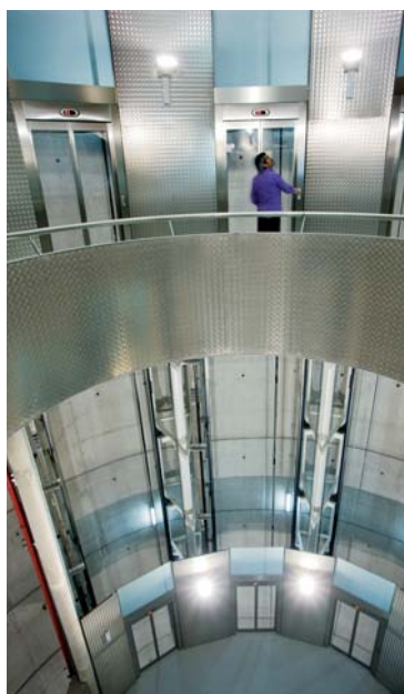
Paradas inferiores de los ascensores
