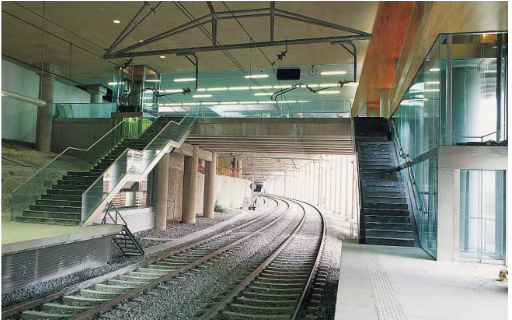
La plataforma se sitúa sobre las vías
